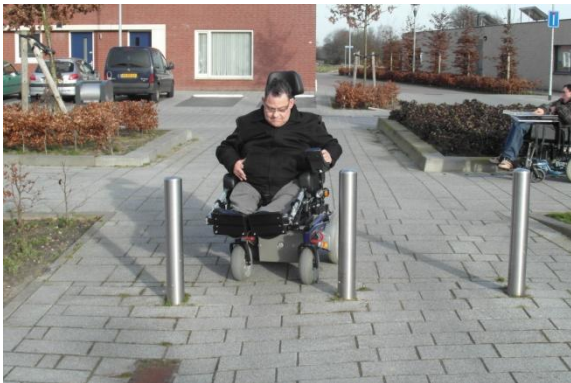
Drie palen waardoor ruimte tussen palen te smal voor man met rolstoel.
